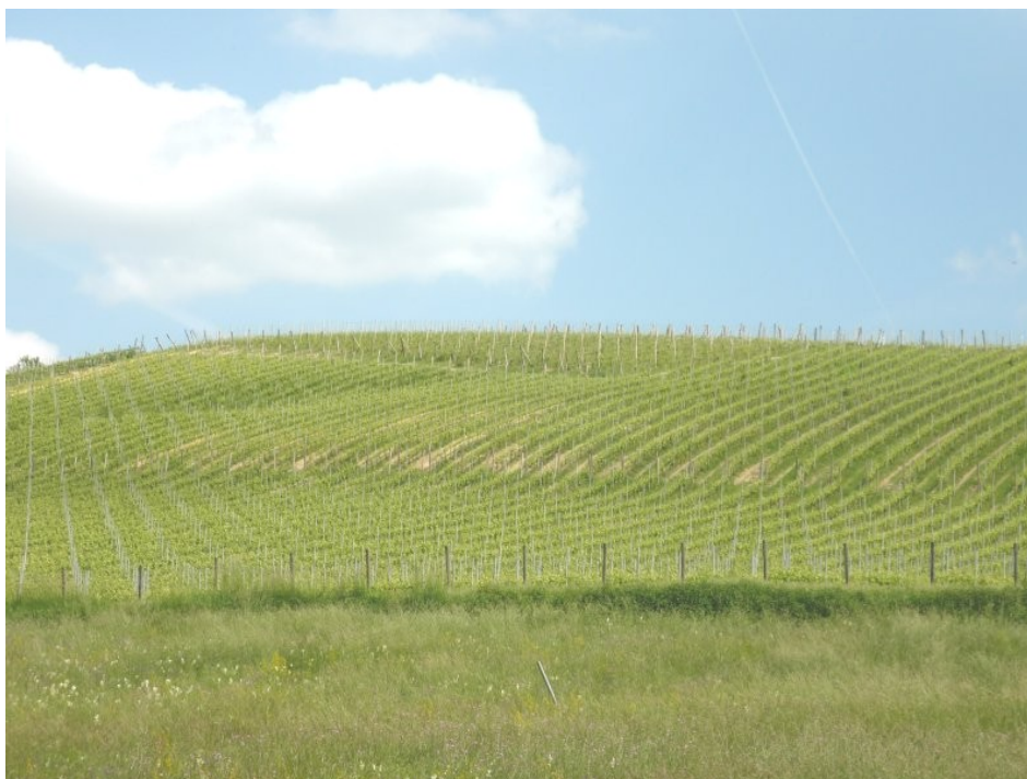
Foto 9.2 – Particolare del fenomeno franoso 33-FA10 in cui si evidenzia la zona di nicchia, anche se parzialmente obliterata, e la porzione di versante immediatamente a valle marcatamente deformata.
